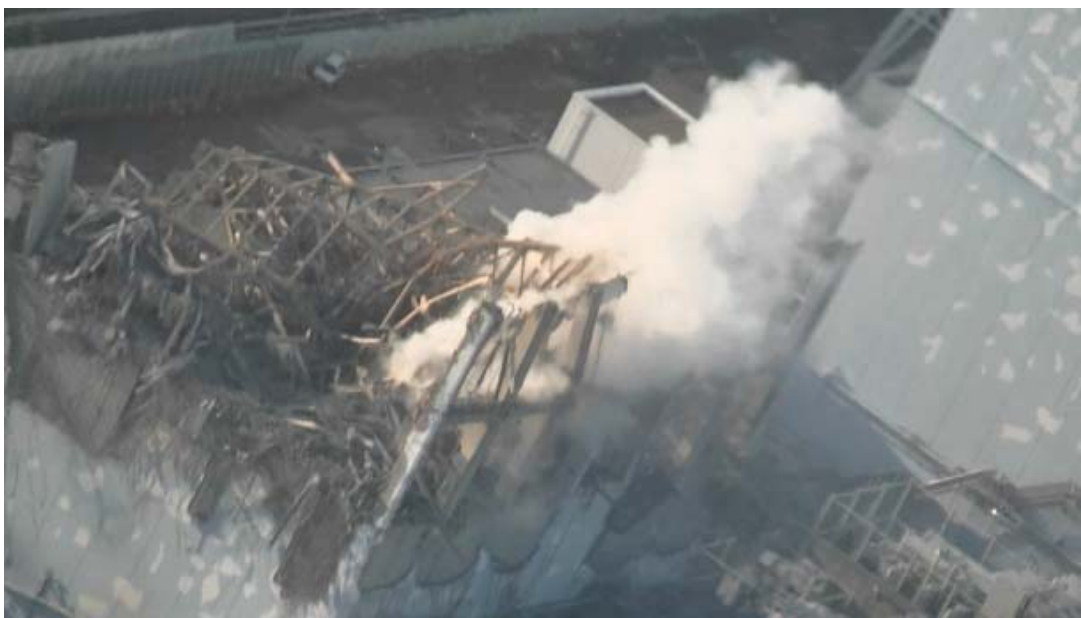
写真2.2.4-1 182 （水素爆発後、白煙を上げる3号機）
